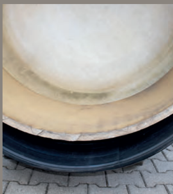
5. Die Sackbildung unterhalb des Rohres verschwindet mit Anziehen der Spannbänder.
