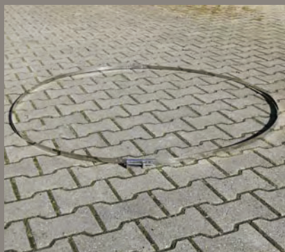
1. Vorbereitung der Spannbänder.
