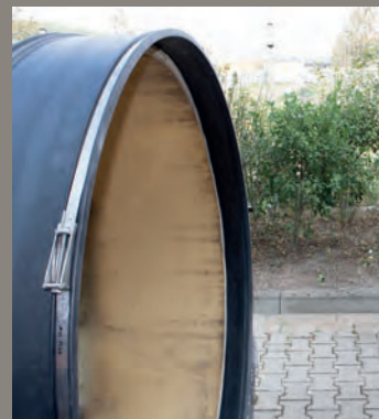
3. Gummidichtung mit Spannbändern auf größerem Rohr positionieren.
