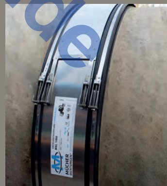
6. Scherband montieren. Wechselseitig anziehen. Scherbandenden liegen übereinander.
